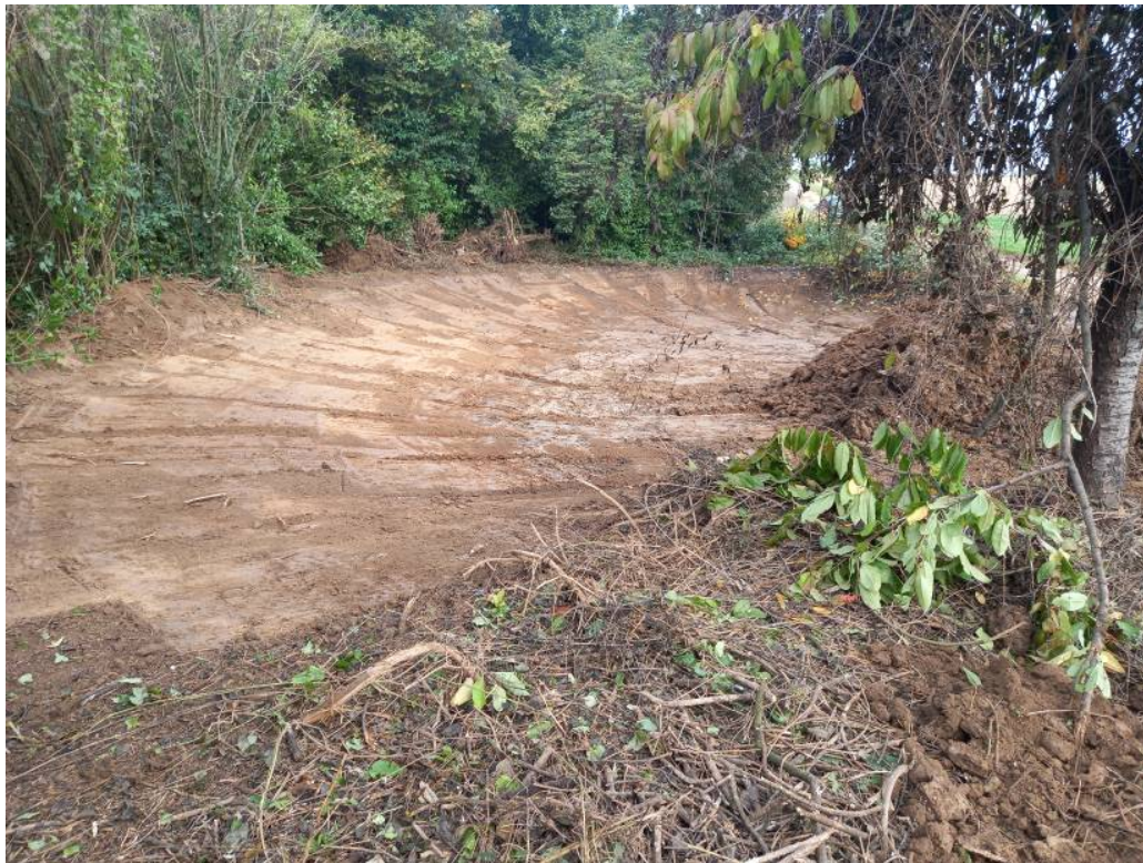
Abb. 4: Hxh-7 im Oktober 2022 während der Ufergestaltung; Blick nach N
