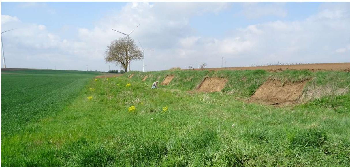
Abbildung 8: Freigelegte Böschungsfenster am Gollenberg (27.04.2022, Foto: A.Konrath).
